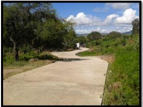
Utilizando cemento previamente adquirido y con una inversión de \$104,480.00 por materiales y con la aportación de la mano de obra de los beneficiarios se construyeron 2400 metros cuadrados de concreto hidráulico en acceso a la comunidad de El Soto pegando este tramo con carretera federal.
